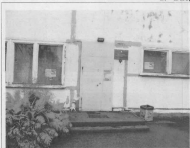
Фото 3 Входная площадка, лестница (наружная)
