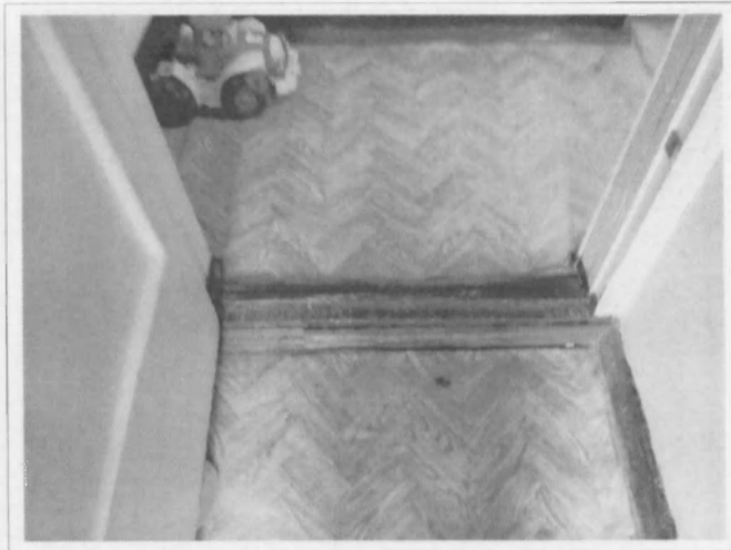
Фото 14 Дверь внутренняя входная (вход в группу)
