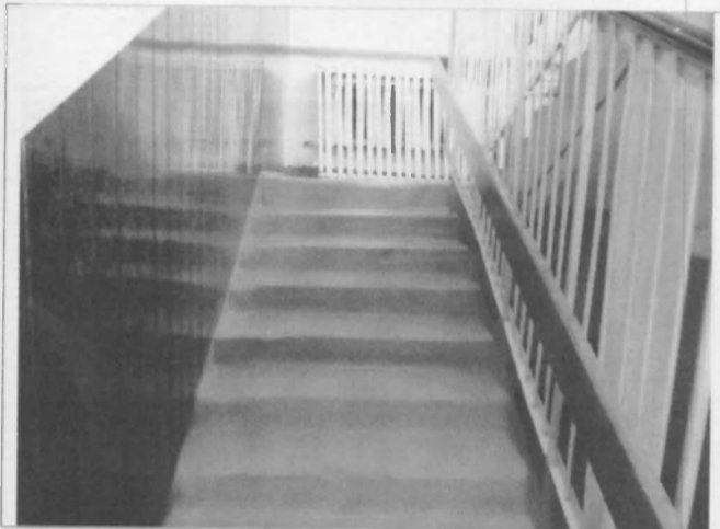
Фото 21 Внутренние лестницы (междуэтажные)
