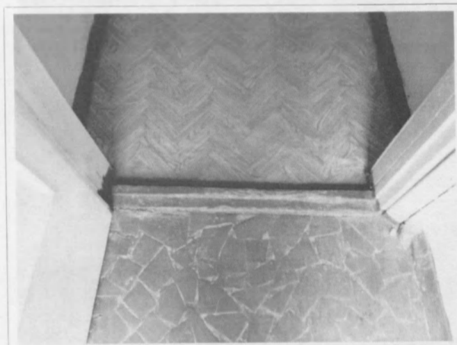
Фото 12 Дверь внутренняя входная (вход в группу)
