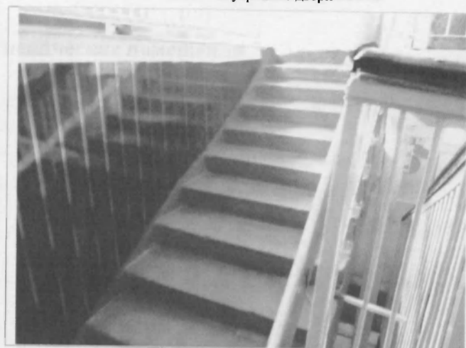
Фото 22 Внутренние лестницы (междуэтажные)
