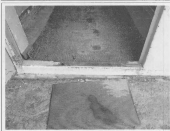
Фото 5 Дверь внешняя (входная)
