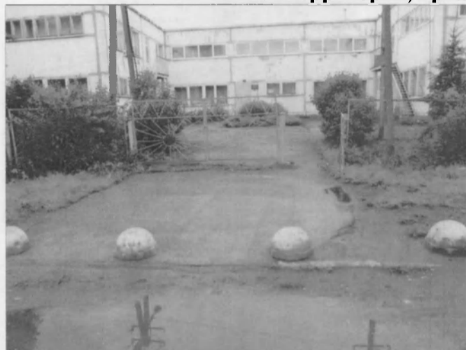
Фото 1 Путь (пути) движения на территории (вход на территорию, калитка)
